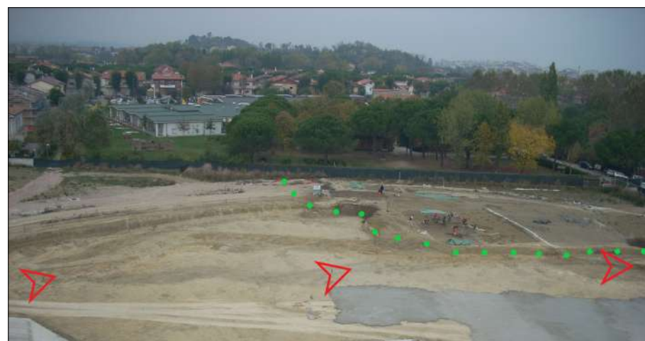
Fig. 3. Settore nord-occidentale del cantiere dopo lo sbancamento areale: tracciato del paleoalveo (freccie rosse) e settore con strutture di abitato (oltre i puntini in verde).
